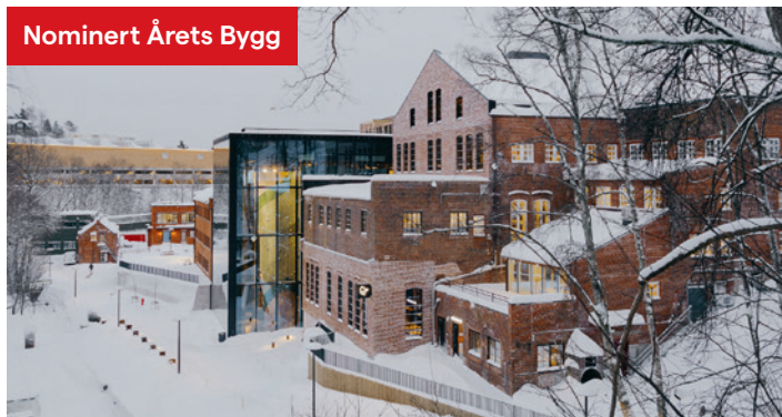
FÅD – Vollsveien 13H
