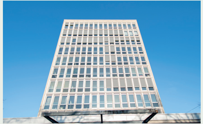
Høyblokka er elleve etasjer og nesten 40 meter høy.
