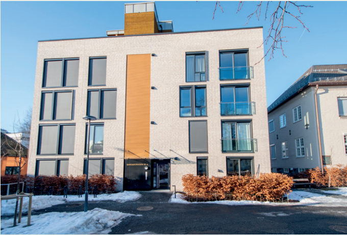
Sydblokka var det første bygget som ble påbegynt på Torshovhøyden i 2020.
