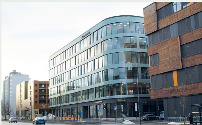
Medisinsenteret glir inn i rekken av nyere forretningsbygg.
