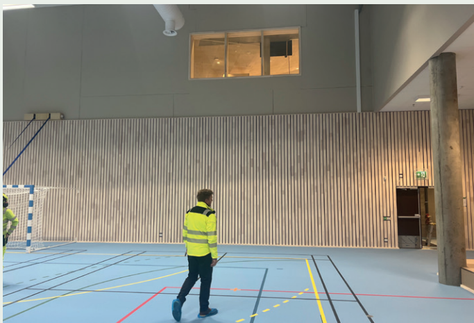
Stavangers prosjektleder Jan-Reidar Hammer i idrettshallen. Vinduet står i vegg mot skolens aula.
