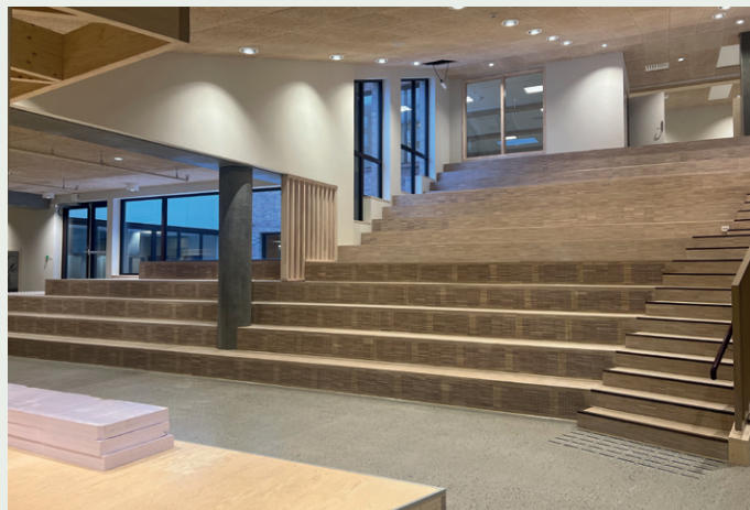
Deler av skolen er nedgravd i terrenget.
