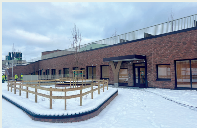
Fra skolens uteområde, med Y-inngangen til høyre, ligger på taket av barnehagen
