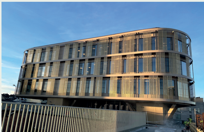
Kontorbygget i massivtre rager høyest i prosjektet. Foto: Torjus Sinnes, Skanska.
