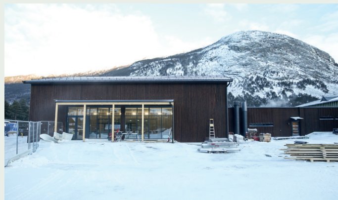
Bygget der opplæringsbassenget er plassert, og garderobeanlegget til høyre, er nybygg. Fasaden er royalimpregnert trekledning.
