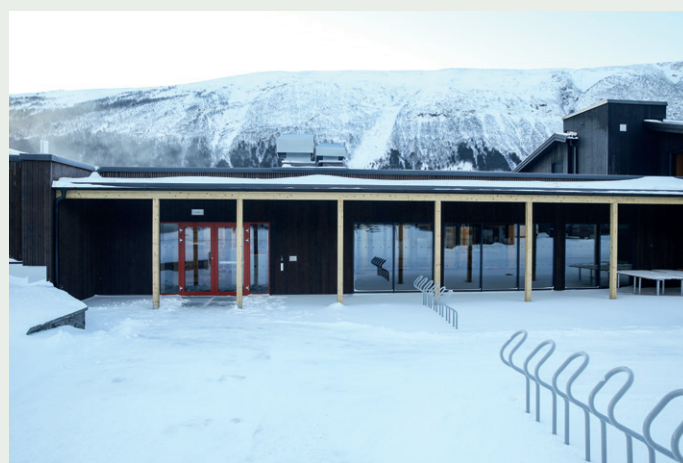
Det nye inngangspartiet til Skjåkhallen.
