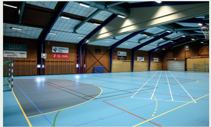
I idrettshallen er det lagt nytt gulv og lagt inn LED-armatur som lyskilde i taket, samt at ventilasjonsanlegget er tilknyttet det helt nye tekniske anlegget.
