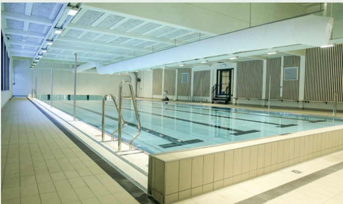
Betongen er gjenbrukt. Treullitten i taket er også gjenbrukt, med et strøk maling.
