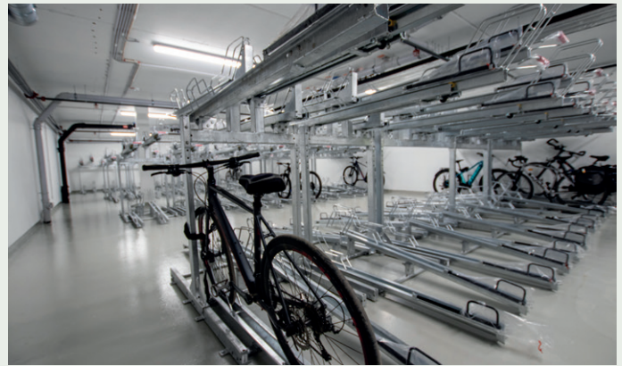
Under det ene bygget er det en stor sykkelparkering.
