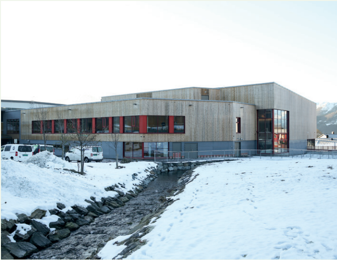
Elva som renner rett forbi og idrettshallen vegg i vegg gjorde at den cirka sju mål store tomte ble vanskelig å utnytte. Cirka 2.200 kvadratmeter er bebygget.
