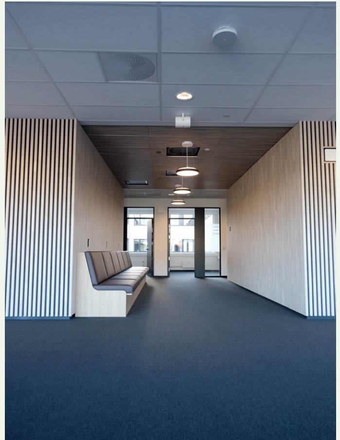
Det er brukt spiler og akustiske treplater på veggene innvendige.
