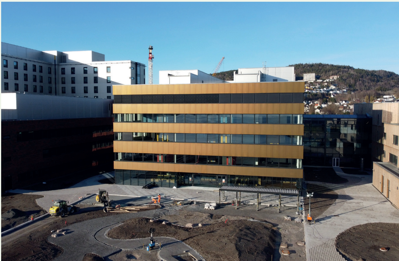
Alt utomhusarbeid i prosjektet utføres i en separat entreprise, og ferdigstilles nærmere sykehusets åpningsdato i august 2025.
