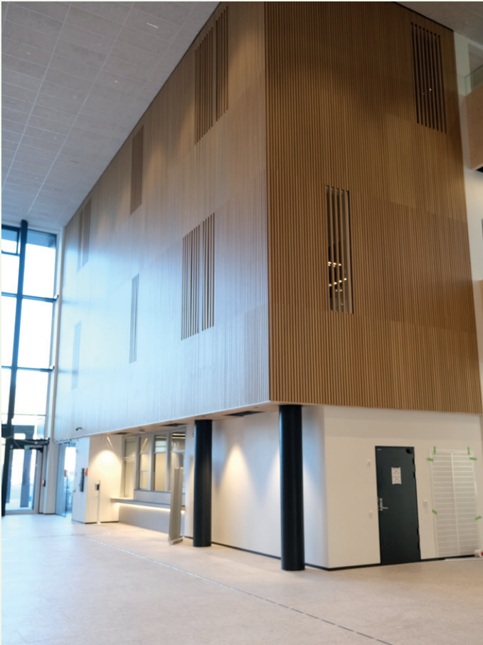
Kuben midt i bygget strekker seg over tre etasjer, og rommer blant annet skolelokaler for pasienter i skolepliktig alder.
