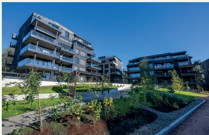
Totalt består trinn 1 i prosjektet av 142 leiligheter samt seks næringslokaler. Foto: Eidra/Torbjørn Sandberg
