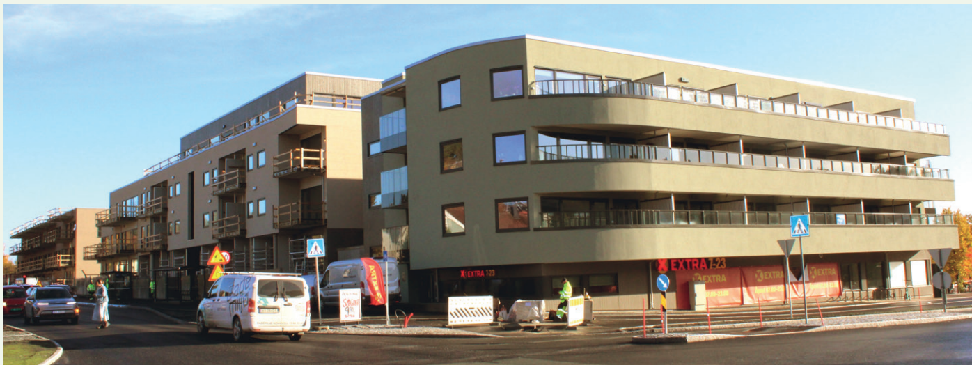
Nærmest en av de to innflyttede blokkene, og bakover langs gata de to som fortsatt er under arbeid.
