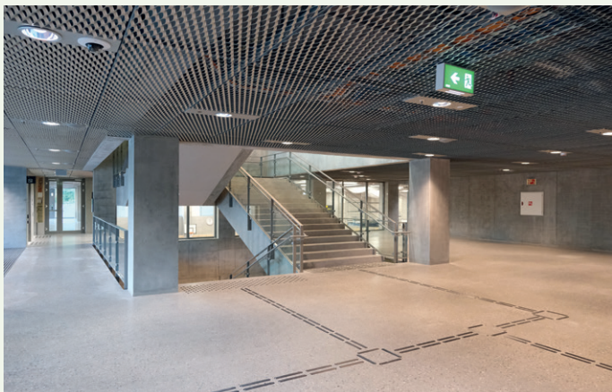
Betongkonstruksjonen er godt synlig både utvendig og innvendig.
