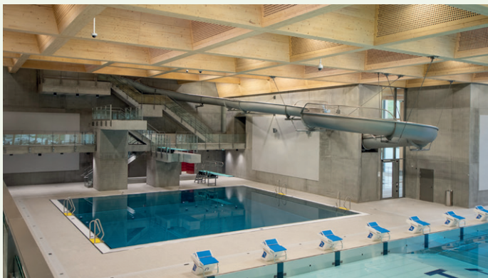
Stupebassenget er tolv ganger 13 meter stort, og har stupebrett på én, tre og fem meters høyde.
