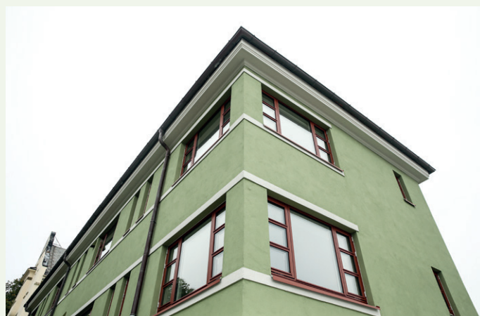
Grønnfargen i STO-pussen på fasaden skal være den opprinnelige fra da bygget var nytt i 1937. Vinduene er nyproduserte kopier av de opprinnelige vinduene, levert av NorDan.
