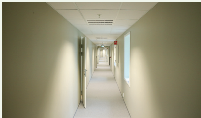
Gangarealet har vinylbelegg på gulv, gips på vegger og systemhimling.
