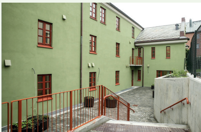
Baksiden av bygget har fått uteområde med belegningsstein. Her var det tidligere fjell inntil bygget.
