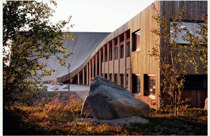
Fasaden er kledd med stående trekledning i malmfuru, mens taket er kledd med kebony.
