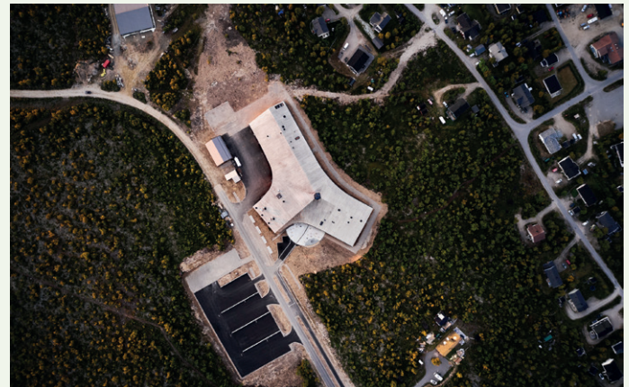
Bygningsformen er inspirert av det innerste leddet i et reinsdyrhorn, kalt mátta, med fløyer som strekker seg i tre retninger.
