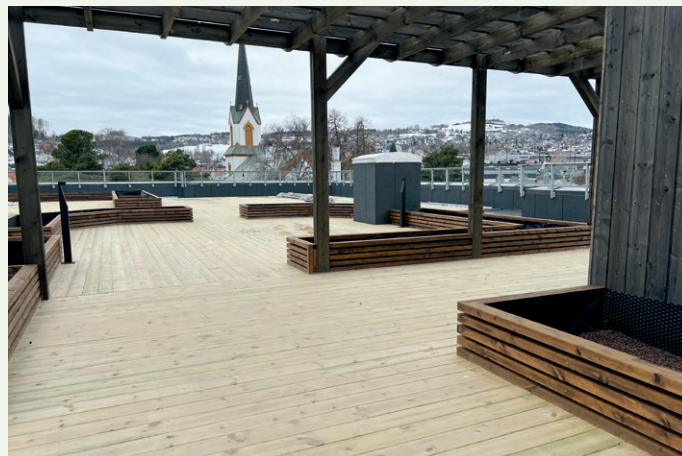
På taket av den ene blokka disponerer leilighetskjøperne en stor felles takterrasse.
