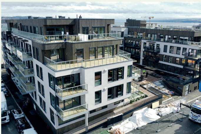
Prosjektet har to boligblokker med et stort uterom mellom. Utomhusområdet ferdigstilles på vårparten.
