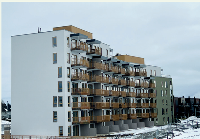
Første byggetrinn er nå fullført, og består av 66 leiligheter.
